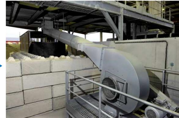
2. Un système de **soufflerie** permet de séparer les éléments imbrûlés.
