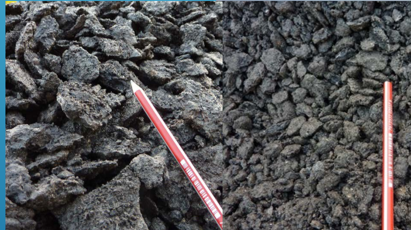
RAP base layer
