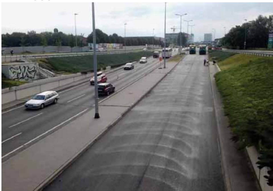
20 / Armaturne mreže za asfalt
