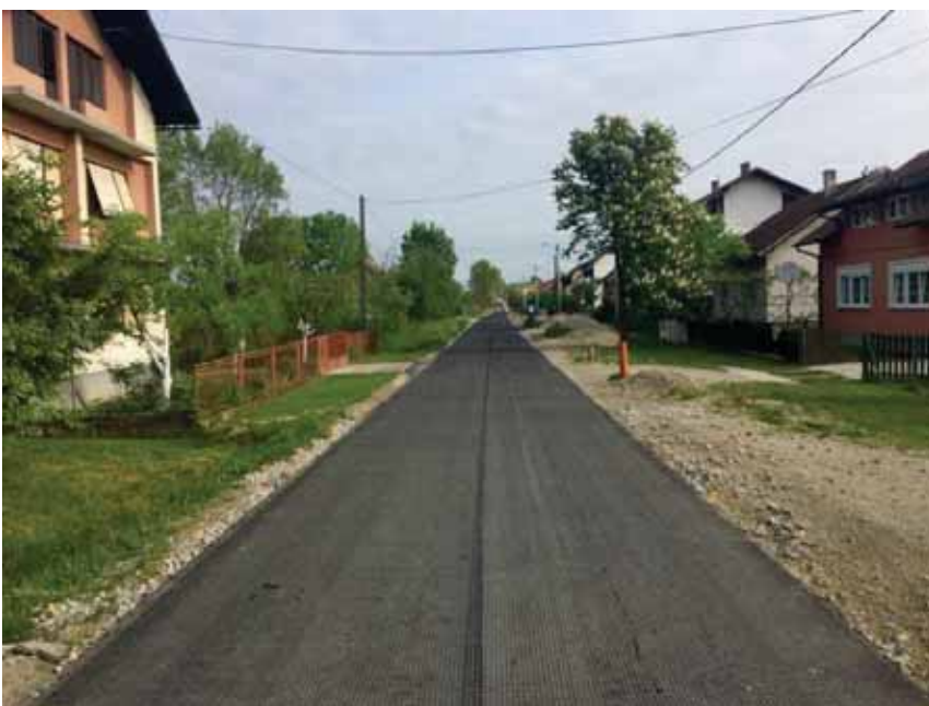
18 / Armaturne mreže za asfalt
