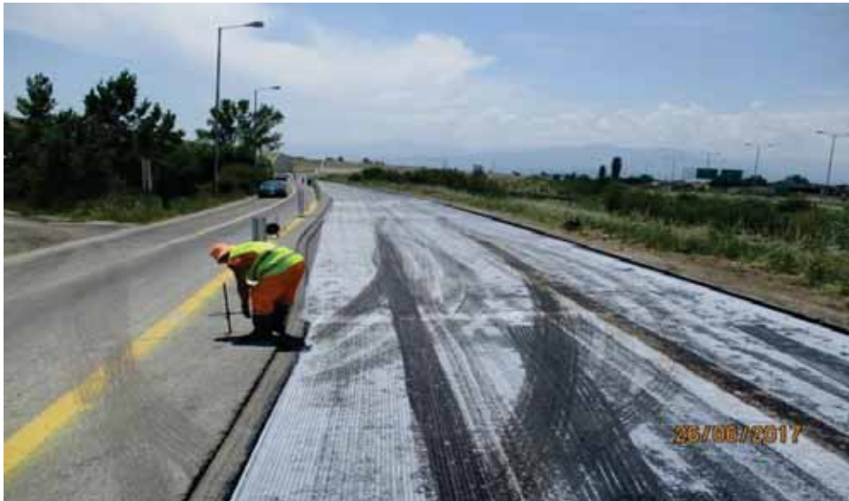
11 / Armaturne mreže za asfalt
